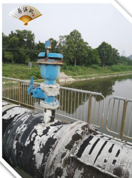
東江水管水閘
