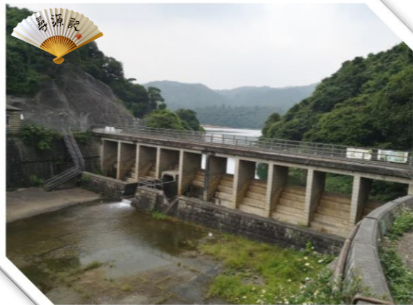
溢洪壩(1901-1910)及其旁的溢洪壩記錄儀器(1901-1910)
