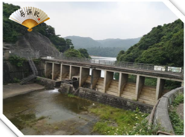
溢洪壩(1901-1910)及其旁的溢洪壩記錄儀器(1901-1910)
