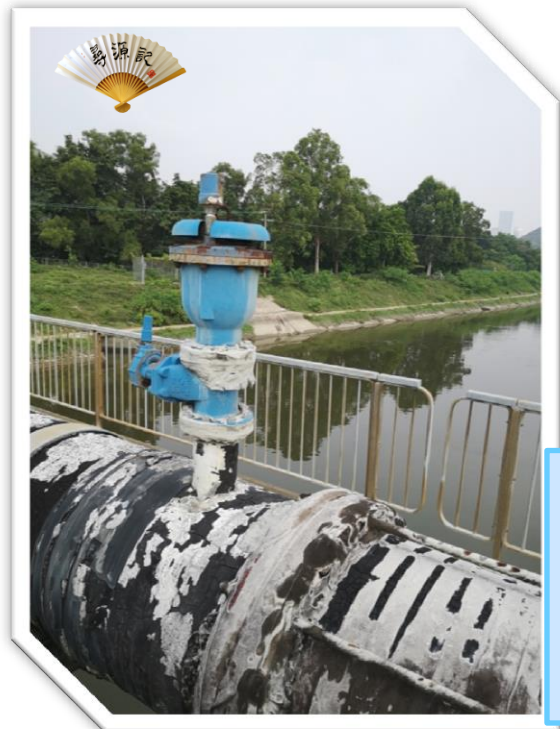
東江水管水閘
